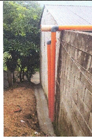
Foto 4: Finalización de Mejoramiento de la cuneta de concreto.
