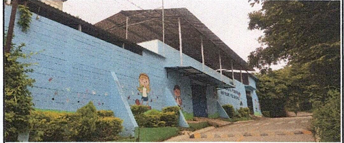
Foto 2: Finalización del mejoramiento de estructura de techo.
