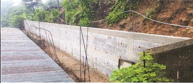
Foto 1: Finalización del mejoramiento del muro perimetral.
